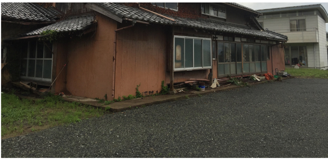
空き家リノベーション着手前
