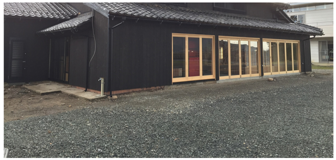
空き家リノベーション完成後
